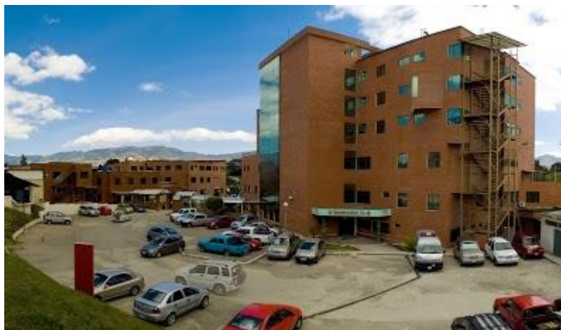
Imagen 1 Hospital UTPL Fuente: Autor Elaboración: Geovanny Guamán H
